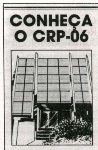
Na capa deste folheto, a fachada da nova sede do CRP-06, à Rua Borges Lagoa, no bairro de Vila Mariana, em São Paulo.
